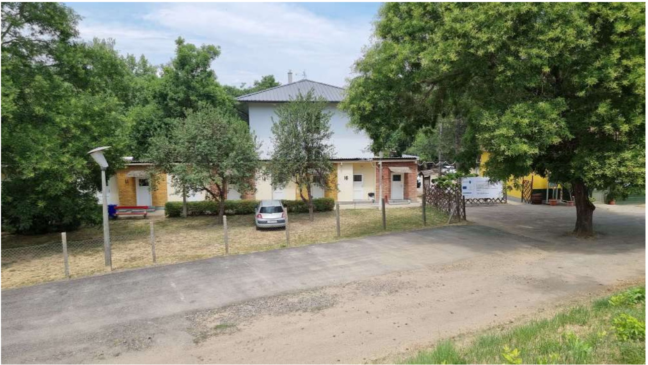
2421 hrsz-ú ingatlan és az előtte lévő útszélesítésre szolgáló közterület. Forrás: Saját fotó
